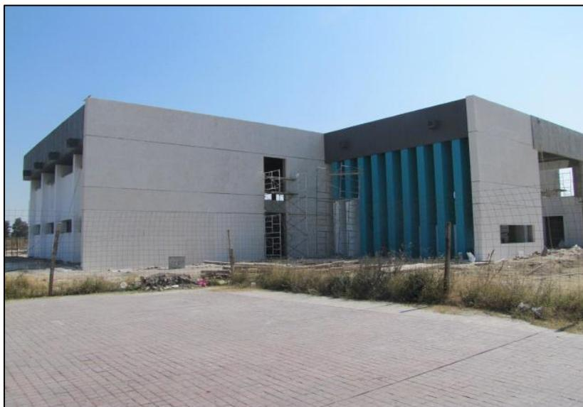
Falta colocación de lámparas, construcción de cisterna y planta de tratamiento. Así mismo, es necesario ejecutar la acometida eléctrica e hidráulica. Se estima un avance de obra del 90%, (foto 7). Resalta mencionar que la UPGTO interpuso un proceso legal en contra de la constructora, por incumplimiento de contrato,
