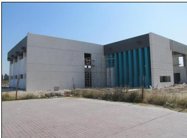
Falta colocación de lámparas, construcción de cisterna y planta de tratamiento. Así mismo, falta ejecutar la acometida eléctrica, hidráulica y de datos. Se estima un avance de obra del 90%.(foto 7)
