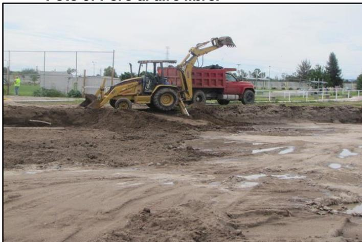
En este espacio se construye el foro al aire libre, con una capacidad para 300 personas. Actualmente se realiza el trazo y la excavación del área para posteriormente llevar a cabo la cimentación, (foto 9).
