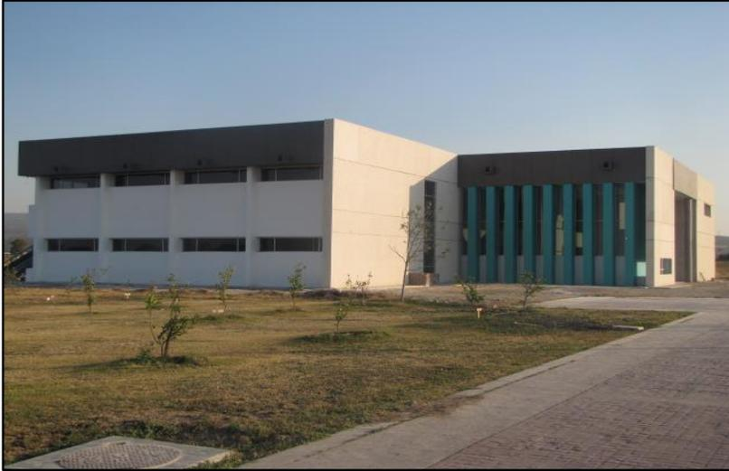
La obra del edificio de biblioteca sigue suspendida. Resalta mencionar que la STYRC, el INIFEG y la SEG, ya están tomando acciones legales para finiquitar este asunto. Al inmueble le falta colocación de lámparas, construcción de cisterna y planta de tratamiento. Se estima un avance de obra del 90%, (foto 16).
