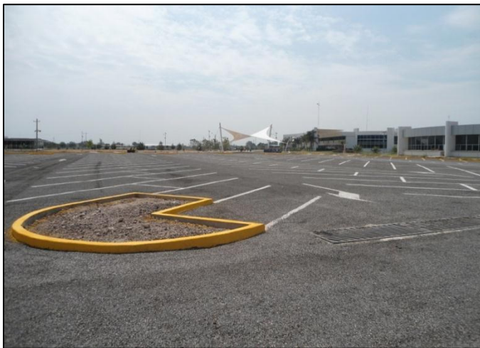
Foto 7. Avance del estacionamiento
